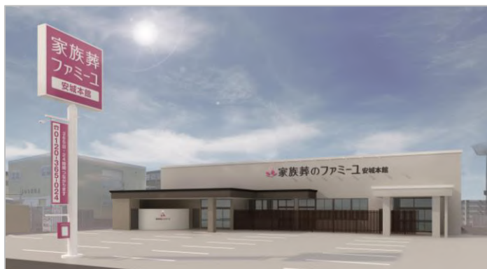
ショールームを兼ね備え、様々な葬儀形式にも対応できる（外観イメージ）
